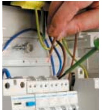
Insteken van een 2,5 mm schroevendraaier is voldoende om de draad uit te kunnen nemen.
