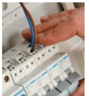
Door de veilige kunststof clip naar beneden te schuiven neemt u de automaat uit.
