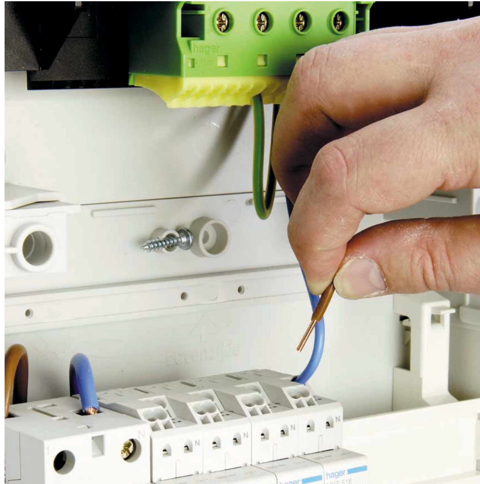
Insteken van een 2,5 mm schroevendraaier is voldoende om de draad uit te kunnen nemen.
